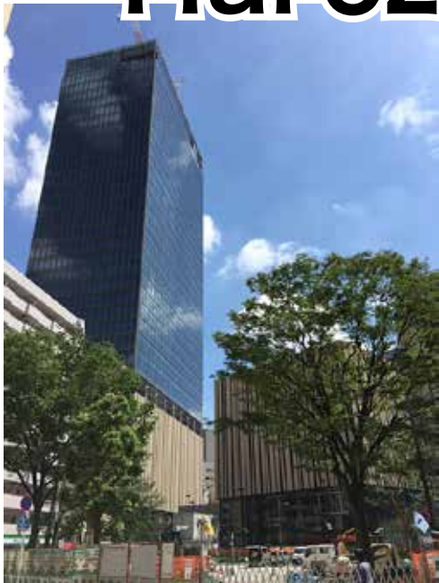
左がオフィスビル、右が劇場ホール 手前は工事の中池袋公園
