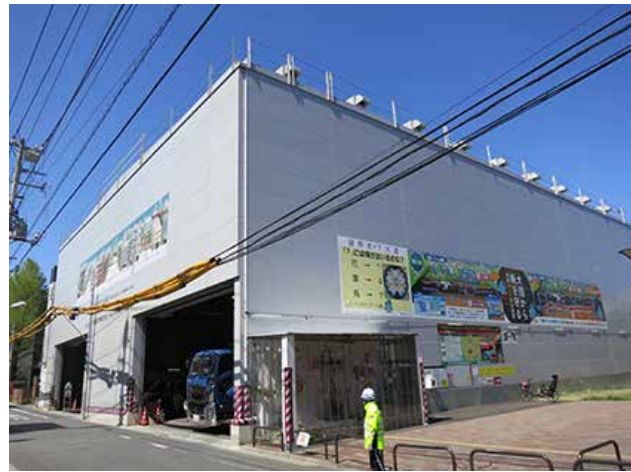
上池袋東公園にある工事起点の建物（上池袋1-30-20）
