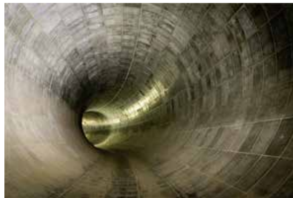
貯留管のイメージ（直径3.75m）
